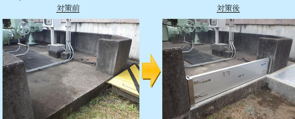
図 耐水化工事例（脱着式止水板設置）
