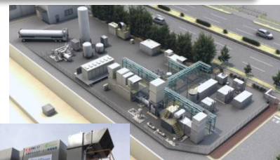
水素混焼ガスタービン
