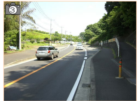
③ 現道拡幅区間 (整備後)
