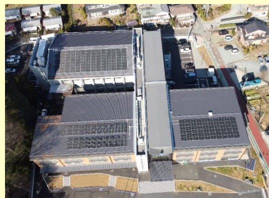
松田町立松田小学校(松田町) 〔太陽光発電システム設置〕
