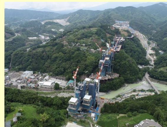
建設中の新東名高速道路(山北町) (令和9年度開通予定)
