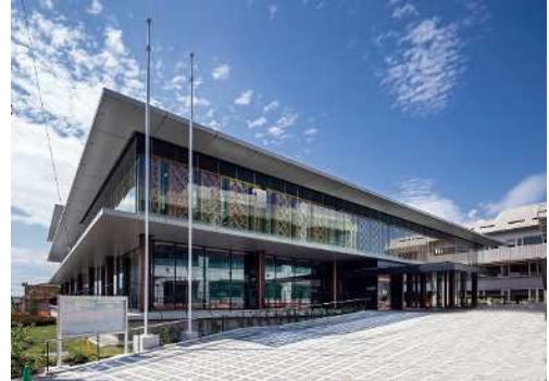
日本初のZEB庁舎・開成町役場
