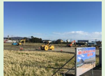
（造成工事の様子）
