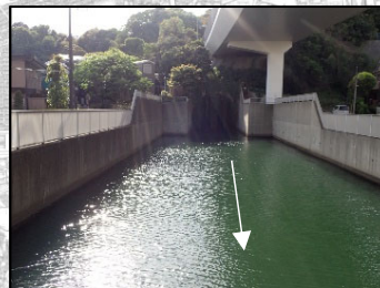
【神奈川県】大岡川分水路出口部
