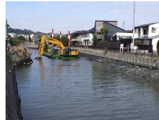
施工状況写真（航路掘削）
