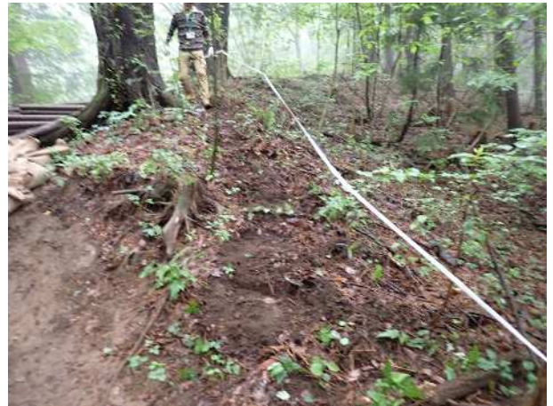
迂回路の設置
