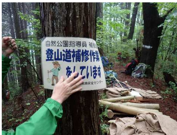
告知看板の設置
