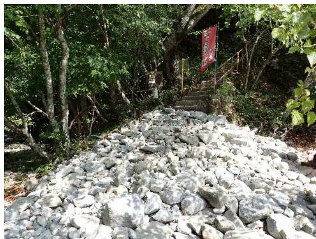
段差解消部分
