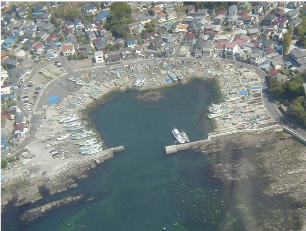
(写真2) 長井漁港漆山地区 (2001年)。
