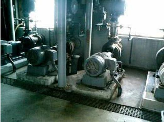
写真1：海水ポンプ（4台設置されており、海水の使用量により稼働させる台数を調整します。）
