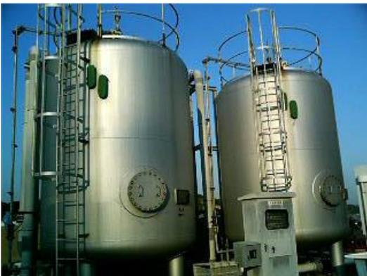
写真2：圧力式濾過タンク（濾材自体も劣化するため、何年かおきに交換しなければなりません。）
