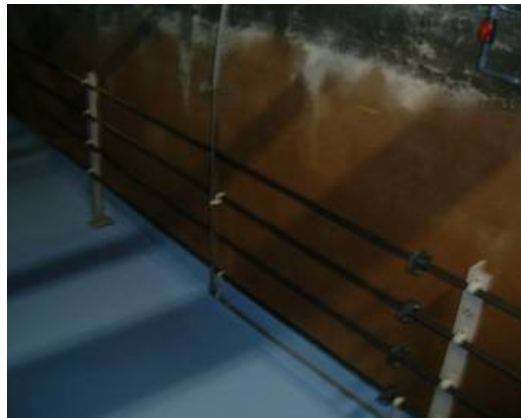
写真4 水槽内加温パイプ
