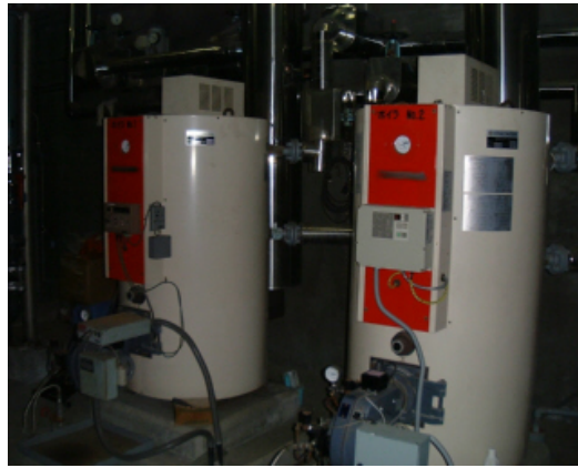
写真2 温水ヒーター
