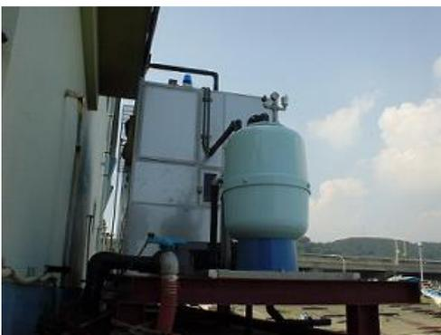
殺菌冷却海水装置。最大8 tの殺菌冷却水をためておけます。手前の青いタンクが濾過器（ろかき）、後ろの銀色の箱が冷却槽及び貯水槽になっています。
