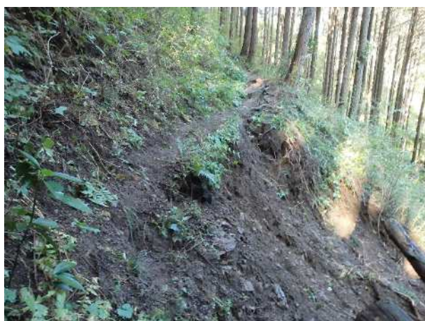
崩落直後の様子（令和元年10月撮影）
