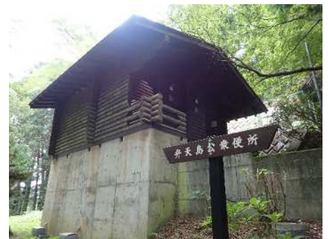
公衆便所の点検
