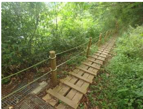
木道や柵の点検
