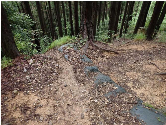
土嚢の水切り
