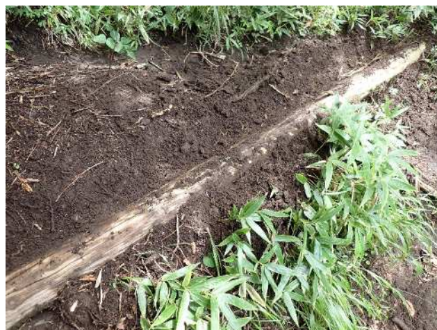
掘削後の水切り
