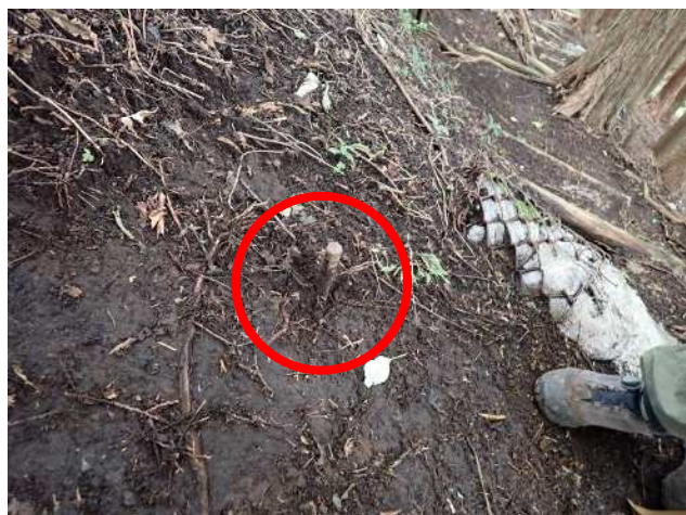
泥がついて見分けにくくなった鉄筋杭
