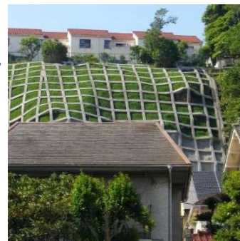
活用例 ▶ 急傾斜地崩壊対策 (横浜市中区内)
