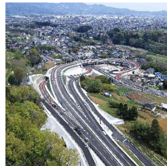
活用例 ▶ 新秦野インターチェンジへの接続道路
