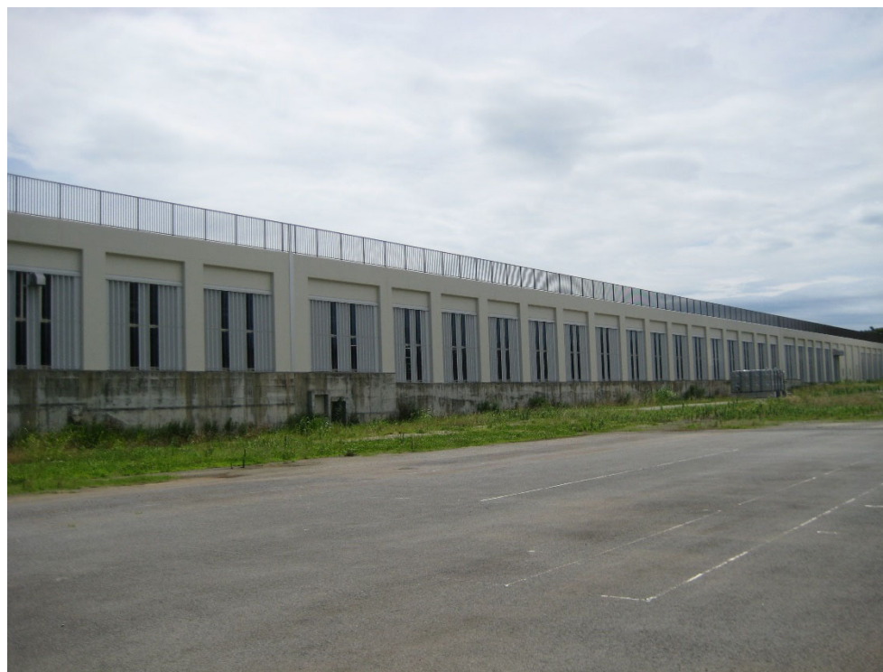
酒匂川流域下水道左岸処理場 水処理施設覆蓋工事
