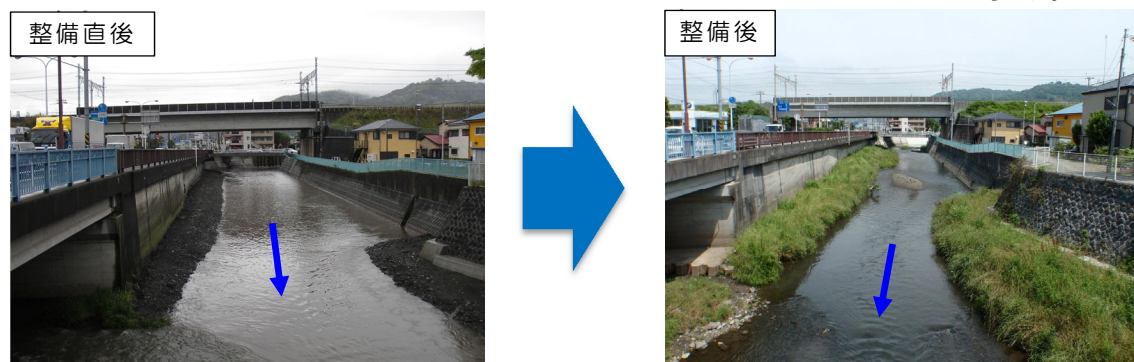
下流区間施工事例
