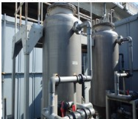
地下水汚染対策（秦野市 浄化施設）
