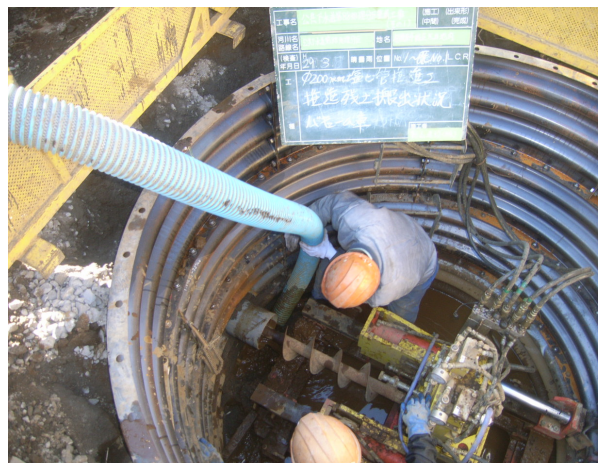
公共下水道の整備（相模原市）
