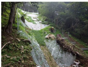
水源林の基盤整備
