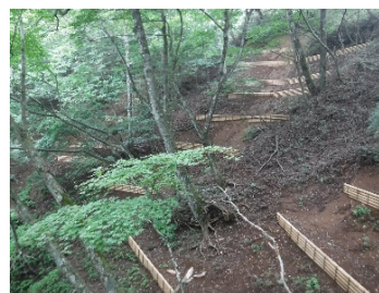
中標高域の自然林の土壌保全対策
