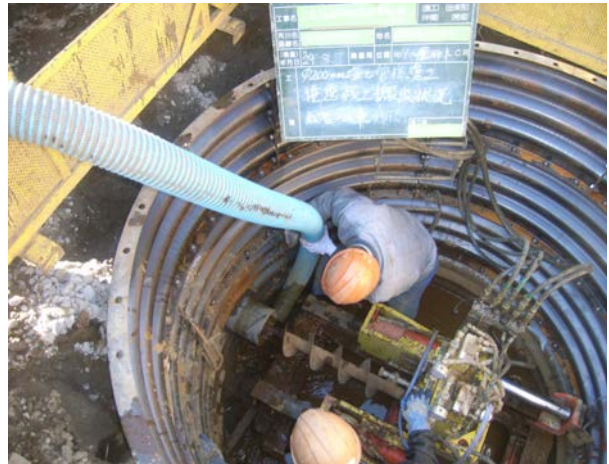
公共下水道の整備 (相模原市)
