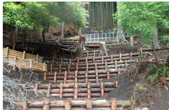
復旧対応後の様子 (土壌侵食防止工)
