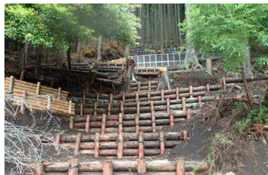
復旧対応後の様子 (土壌侵食防止工)
