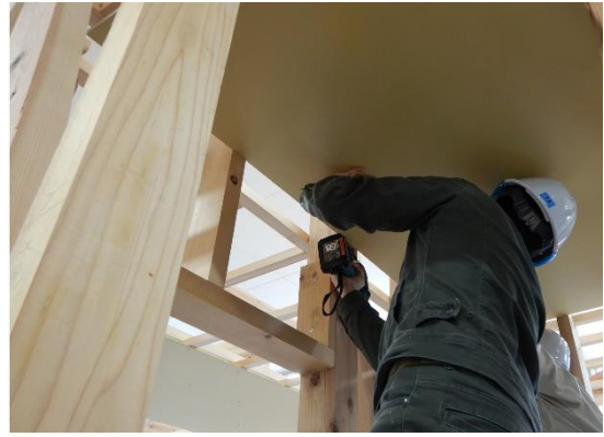
内装仕上工事
