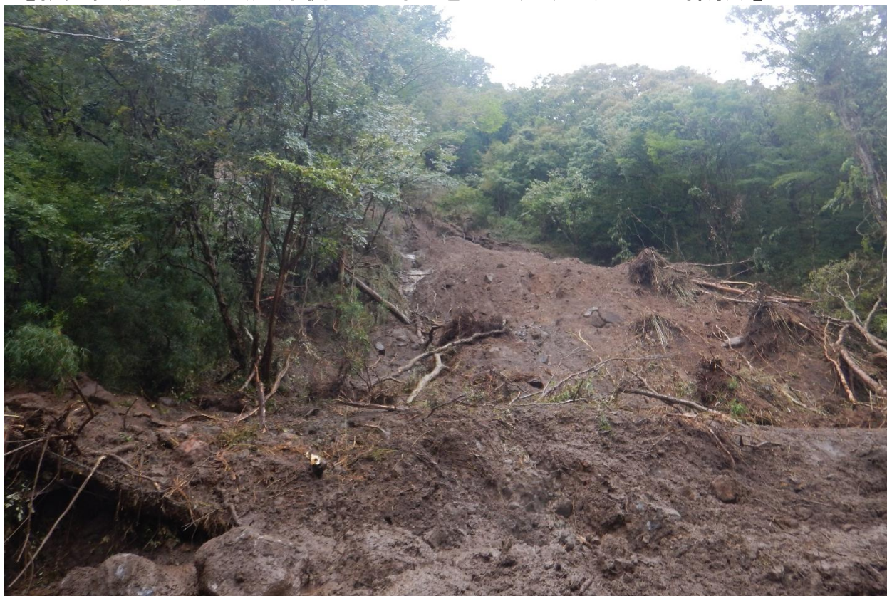
【被災箇所の状況（道路側から斜面を望む）（10月15日撮影）】
