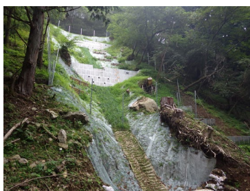
水源林の基盤整備
