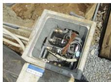
地中熱交換器と横引き配管の接続部
