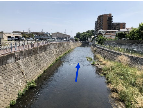
松山橋下流（整備済箇所）
