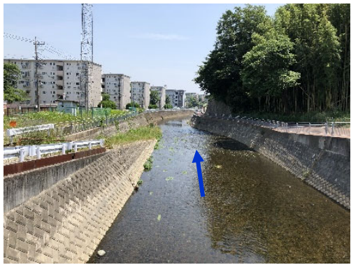
上土棚橋下流（整備済箇所）
