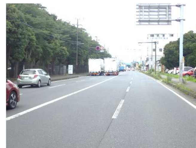
現道拡幅区間
