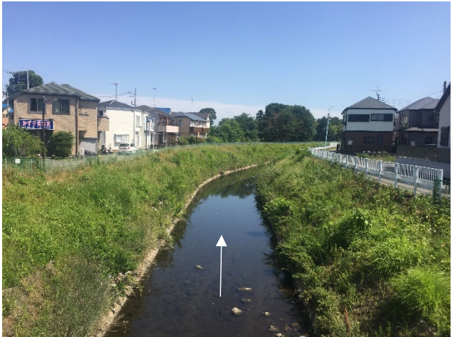
共和橋下流部の様子
