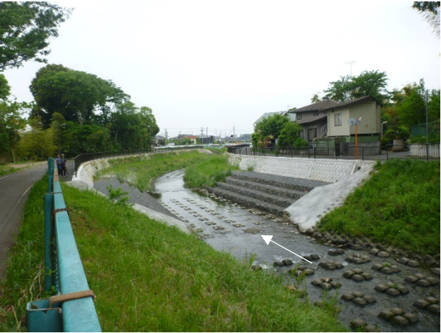
根岸橋上流部の様子
