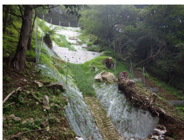
水源林の基盤整備
