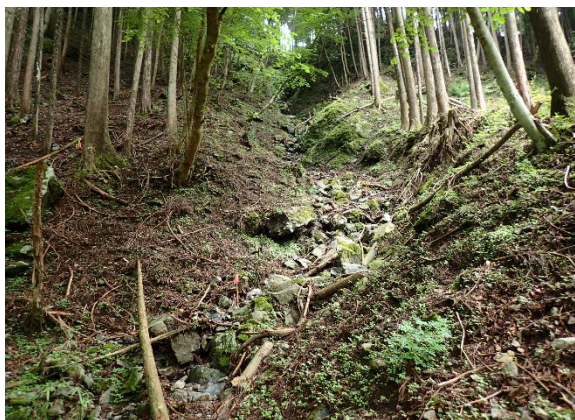
▲施工前（H29撮影）
