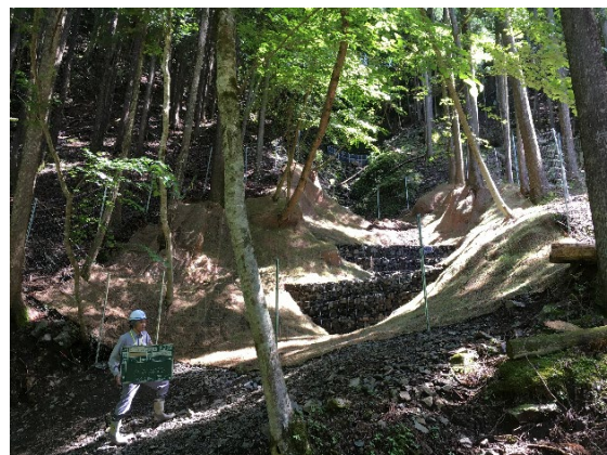
▲施工直後（H30 7月撮影）
