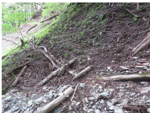
バリケード設置後
