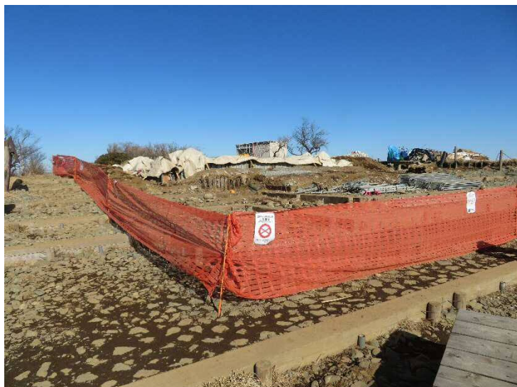
(写真6) 建て替え工事中の休憩所
