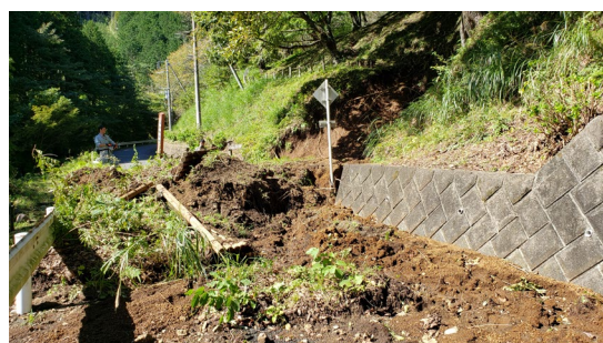
アクセス道（内山林道）の土砂崩れ
