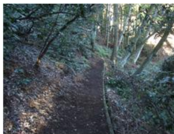
21世紀の森での散策道の倒木除去の様子
