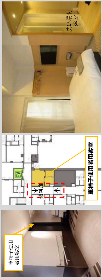
車椅子使用者用客室 共用廊下のスロープ設置により段差解消（車椅子使用者用客室内のフラット化） 洗い場付浴室（便所・脱衣室内で回転スペース確保）
