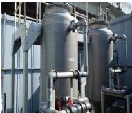
地下水汚染対策(秦野市 浄化施設)
