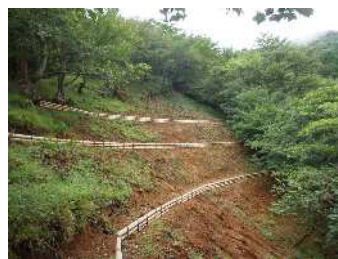
中標高域の自然林の土壤保全対策
