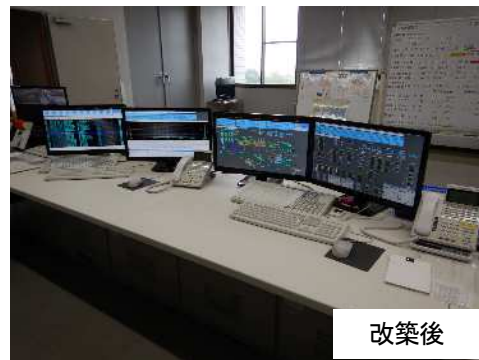
酒匂川流域下水道(右岸処理場) 中央監視設備の改築工事
