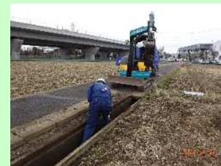
平成31年2月蓋つき水路の泥上げ
