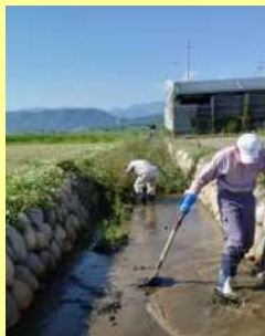
水路の泥上げ
