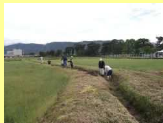
水路の泥上げ
