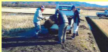
農道整備作業の様子
