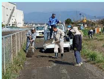
農業用水路の管理通路の補修
