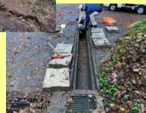
農道側溝の管理
