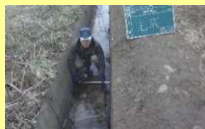
農業用施設の補修 (排水路、水甲等)
