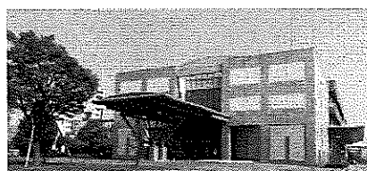
総合防災センター
