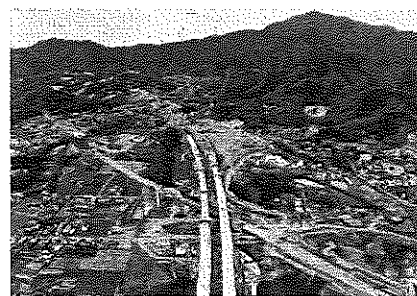
新東名高速道路 伊勢原大山インターチェンジ
