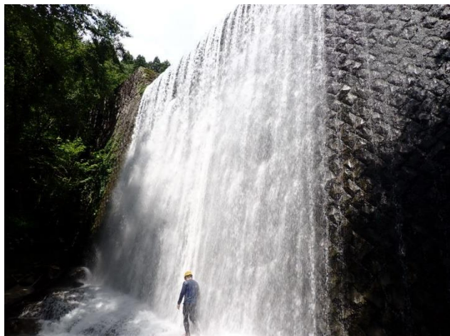
西沢の砂防えん堤
