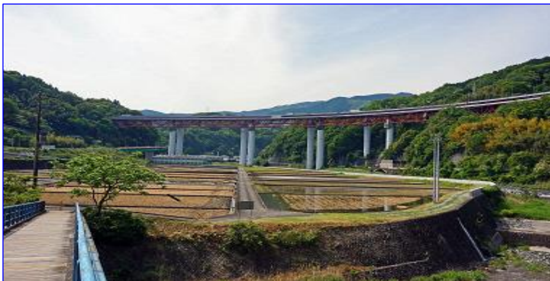
丹沢周辺の里地 里山 里川の風景 (山北町東名陸橋付近)
