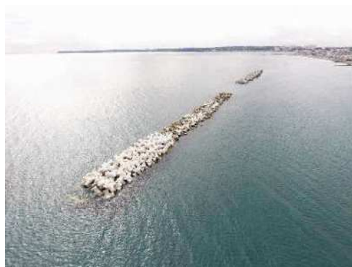
離岸堤（北下浦漁港海岸）
